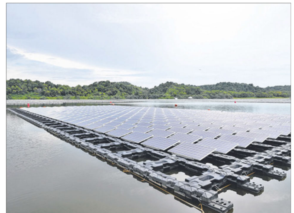
政府计划到2030年将太阳能装机容量推高至2千兆峰瓦，相当于我国到时总电力需求的3%。设在登格蓄水池的胜科登格浮动太阳能厂是全球最大的内陆浮动太阳能光伏系统之一，每年可生产60兆峰瓦电力。（谢智扬摄）
