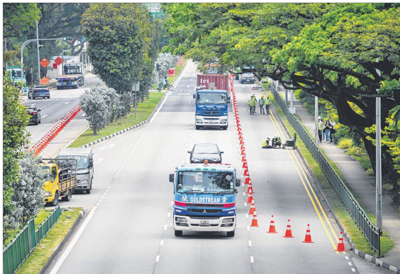
属于城市主干道的西海岸大道今年2月开始试行含回收塑料的铺路材料。（谢智扬摄）
