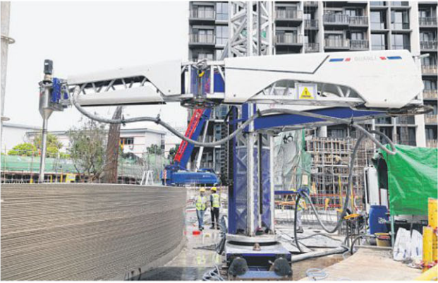
混凝土3D打印技术高度自动化，但由于技术尚未普及，在实际应用前，仍须经过严格验证，确保安全可靠。（萧紫薇摄）
