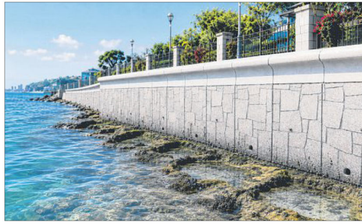
这个可调整高度的海堤由掺入再循环材料的混凝土块建成。混凝土块设有孔洞，可为海洋生物提供栖息和躲避捕食者的空间，有助提升海洋生物多样性。（鹿岛建设提供）
